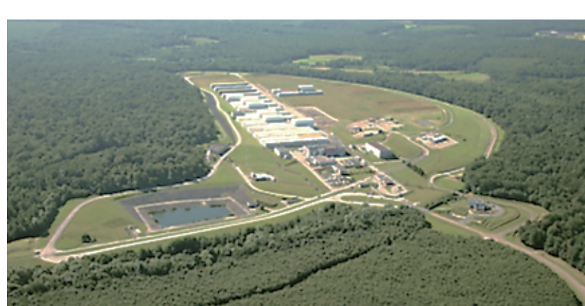
オーブ(フランス) 1992年～ ピット埋設施設
