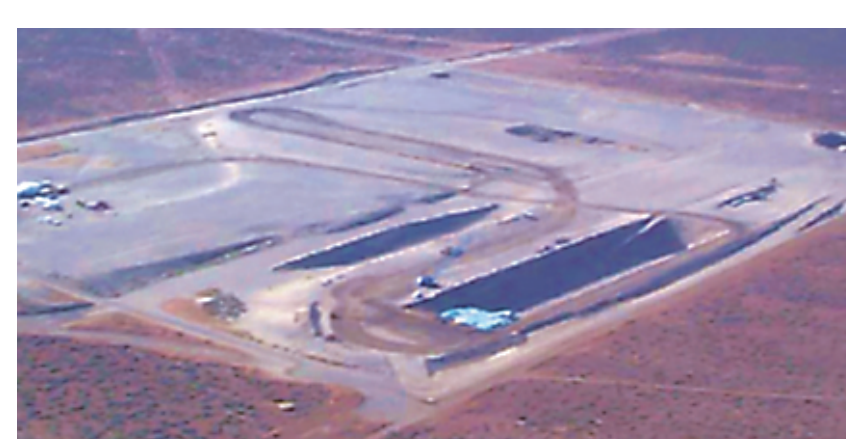
リッチランド(アメリカ) 1965年～ トレンチ埋設施設
