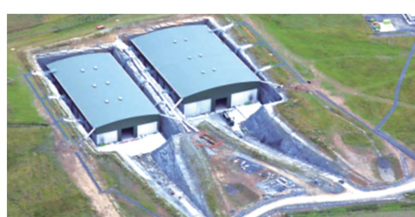
ドーンレイ(イギリス) 2015年～ ピット埋設施設
