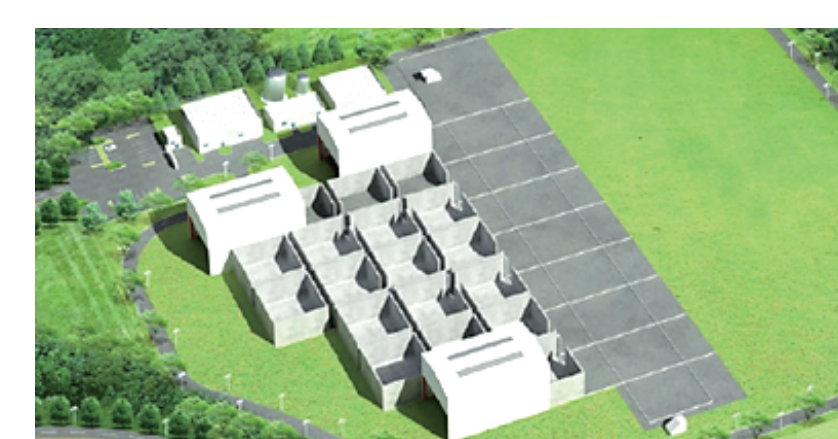
ウォルソン(韓国) 2022年～建設中 ピット埋設施設 韓国原子力環境公社 (KORAD)
